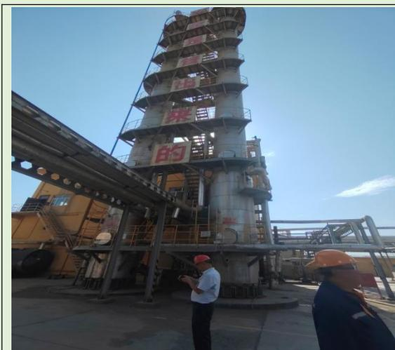
工业萘生产装置初馏塔+精馏塔
