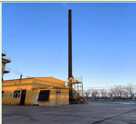
工业萘管式炉排气筒
